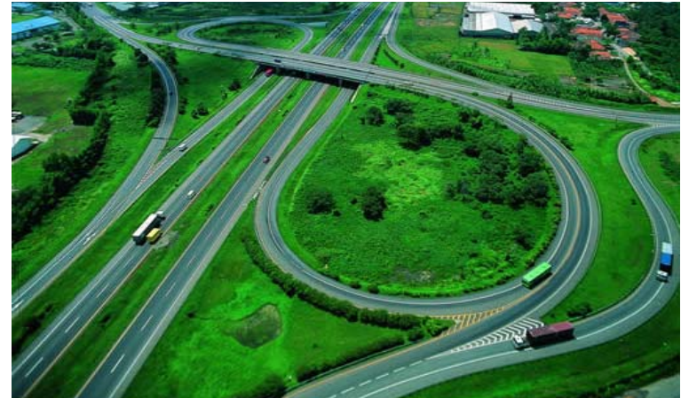
Exit Toll menuju Kawasan Industri Suryacipta
